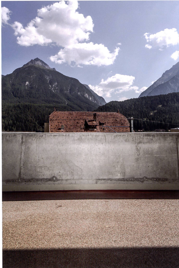
[ABB. 23] Blick von der neuen Talstation Scuol.
