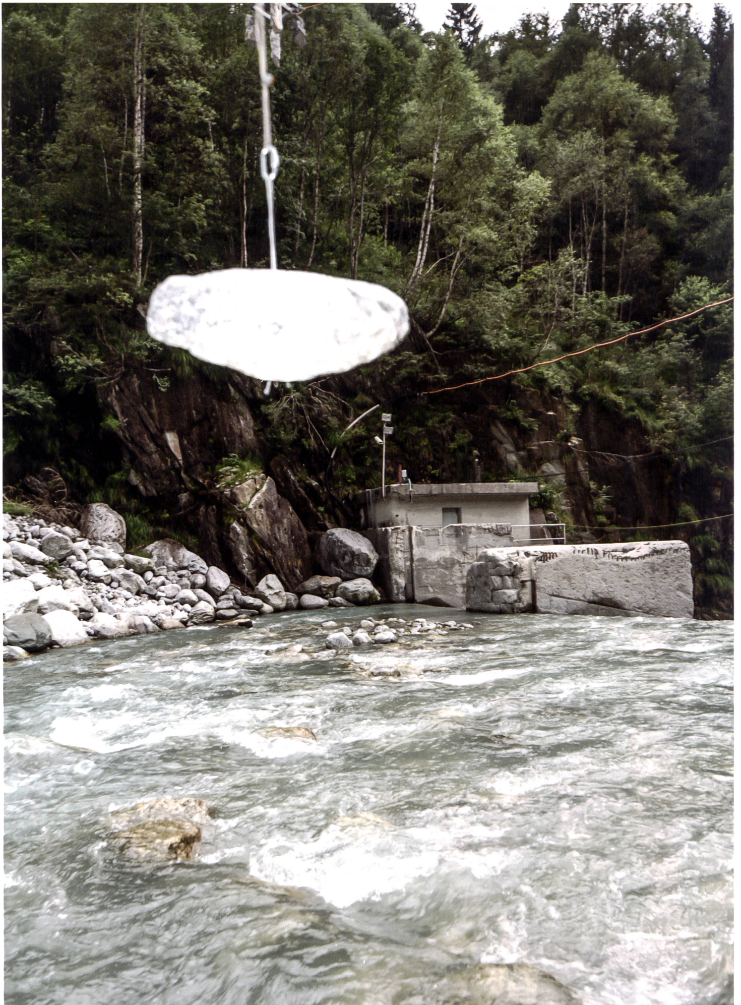
[ILL. 32] La diga del fiume Bondasca colpita da ripetute frane è sotto stretta sorveglianza. Il sasso segnala l'allerta «acque alti» a valle.
