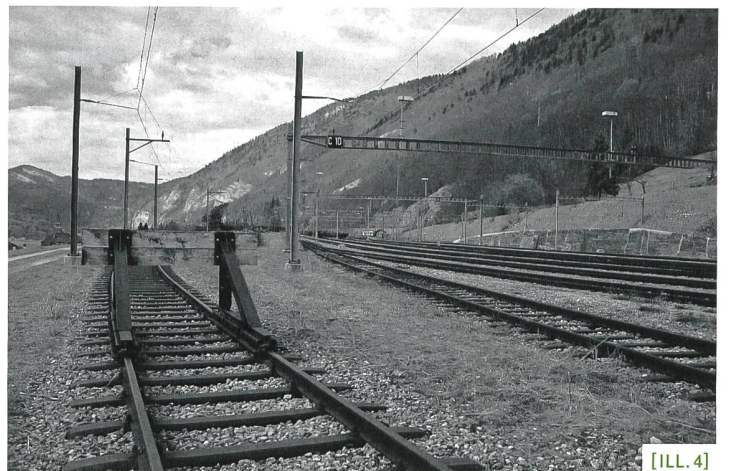
[ILL. 1-4] La plateforme ferroviaire de Vallorbe laissée en attente (Photos: Manuel Rickli)
