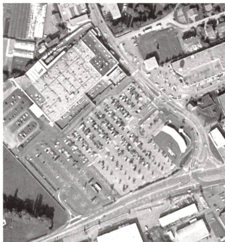
Agglomération de Chambéry (France). Voie Rapide Urbaine (env. 90'000 véh/j) avec son équipement urbain type : centre commercial Carrefour Bassens (9'000m 2 de surface de vente et 1150 places de parc).
