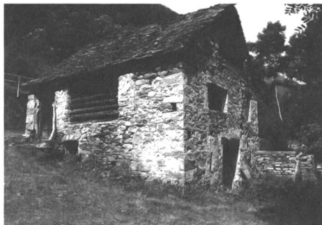
Illustrazione 1: Esempio di edificio meritevole di conservazione dove è ammesso il cambiamento di destinazione (categoria 1a)
