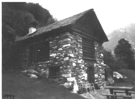
Illustrazione 3: Edifici rustici già trasformati (categoria 3)
