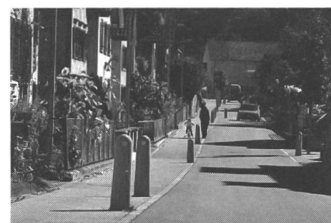
Wangs: Bei der notwendig gewordenen Sanierung dieser Sammelstrasse hätten dem konventionellen Umbau mit Verbreiterung die schmalen Vorgärten geopfert werden müssen. Statt dessen wurde ein Mehrzweckstreifen mit schützenden Wehrsteinen angelegt.
