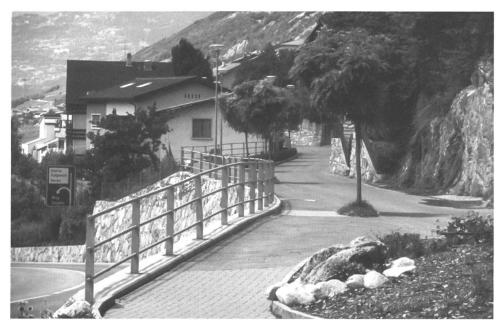
Leuk: Die Sonnenstrasse, ein beliebter Spazierweg am Hang, verfügt über einen grosszügigen Gehbereich auf der Aussichtsseite, der abschnittweise auch von kreuzenden Fahrzeugen benützt wird, weil die Fahrbahn nur 3.2m breit ist. Ein konventioneller Ausbau wäre bedeutend teurer geworden.
