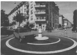
Zürich: Anstelle von Stopstrassen regelt ein «Steinmannli» auf der Kreuzung innerhalb einer Tempo-30-Zone den Verkehr.
