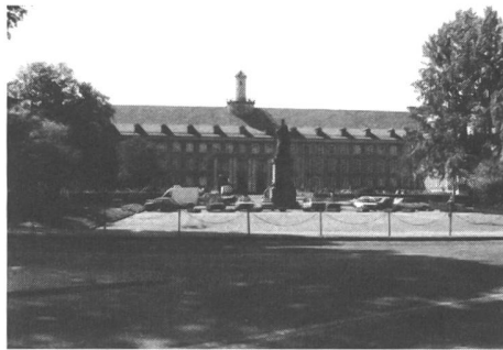
Verwaltungsgebäude der Wojewodschaft Koszalin.
