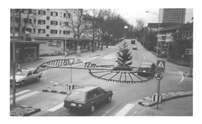
Weil zu schnell gefahren wird, soll der Durchmesser des Kreisels von 17 m auf 24 m (normgerecht) vergrössert werden. Benötigt werden für Fussgänger reservierte Flächen. Um tiefere Geschwindigkeiten zu erreichen. wäre es besser, den Durchmesser auf 20 m zu erhöhen und eine Kreisfläche von 10 m Aussenmass um das Zentrum als Schwelle auszubilden
