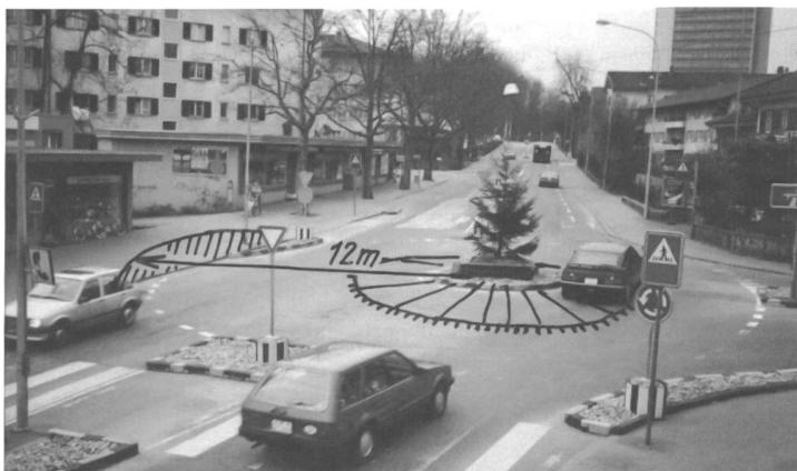
Weil zu schnell gefahren wird, soll der Durchmesser des Kreisels von 17 m auf 24 m (normgerecht) vergrössert werden. Benötigt werden für Fussgänger reservierte Flächen. Um tiefere Geschwindigkeiten zu erreichen, wäre es besser, den Durchmesser auf 20 m zu erhöhen und eine Kreisfläche von 10 m Außenmass um das Zentrum als Schwelle auszubilden
