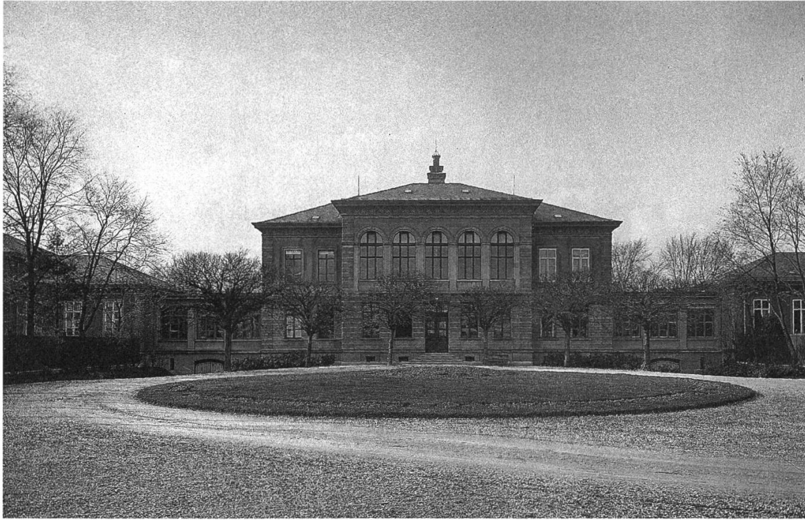
Abb. 28: Verwaltungsgebäude der Irrenanstalt Friedmatt in Basel (ab 1899 Kantonale Heil- und Pflegeanstalt Friedmatt). Aufnahme ca. 1925. Bildquelle: Fotoarchiv Wolf, StABS. Signatur: NEG 1480.
