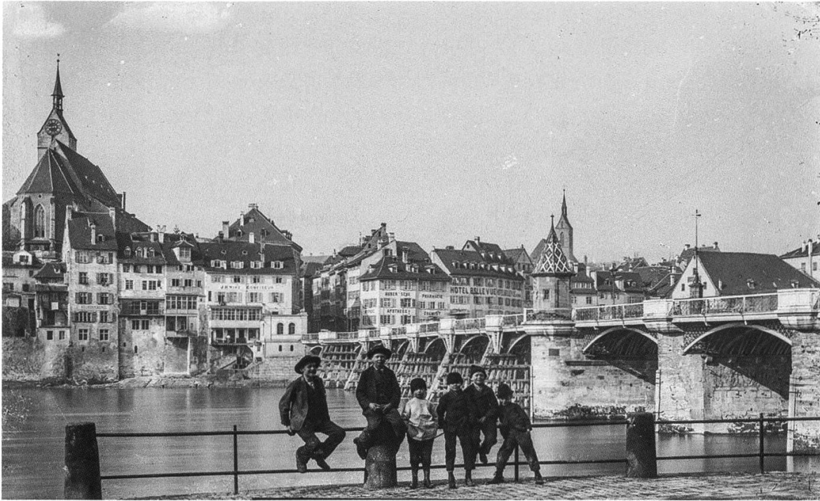
Abb. 6: Alte Rheinbrücke in Basel, Blick von der Kleinbaslerseite (in etwa von Albert Müllers Elternhaus) auf Grossbasel mit der Martinskirche (links). Aufnahme: vor 1875. Foto: Várady. Bildquelle: StABS. Signatur NEG A 1076.
