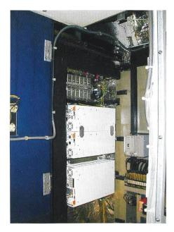
Bild 4. Gesamtes System (Türabdeckung offen) im EW-IV mit Notch-Filter (oben), Booster (Mitte) und Repeater (unten).
