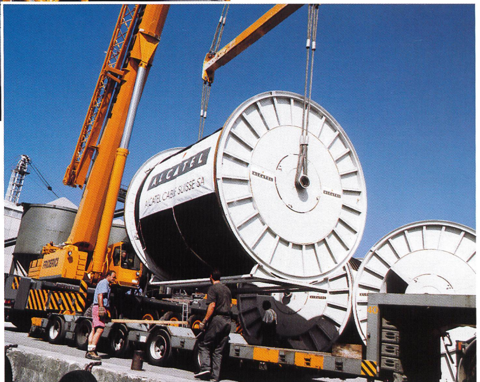
► Kabelhaspel beim Verlad mit Pneukranen.
