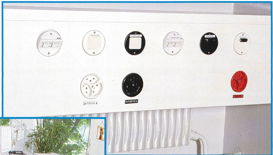
▲ Bild 6. Erschliessung der Endarbeitsplätze im Brüstungskanal: Unten die durch unterschiedliche Farben gekennzeichneten Energiesteckdosen für das allgemeine, das technische und das EDV-Netz.
