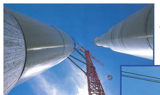
Bild 3. Die beiden Türme, links der alte und rechts der neue Turm. Die Drehkabine an der Turmspitze wurde mit dem Grosshelikopter Kamov montiert.
