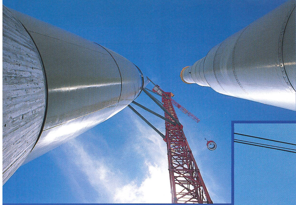
◀ Bild 3. Die beiden Türme, links der alte und rechts der neue Turm. Die Drehkabine an der Turmspitze wurde mit dem Grosshelikopter Kamov montiert.
