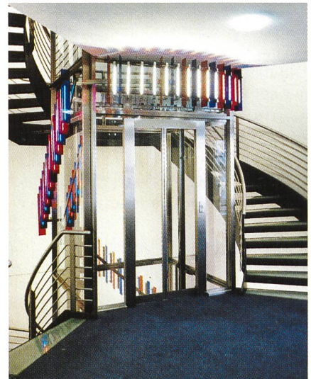
Bild 1. Neue Treppen- und Liftanlage.
