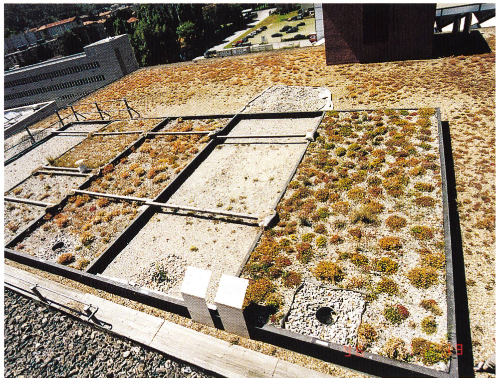
Bild 1. Übersicht über die fünf Versuchsf lächen (rechts Dach 1, ganz links Dach 5) mit unterschiedlichem Pflanzenwachstum. Die Dächer 2 und 5 weisen keine Wasserspeicherplatte auf.
