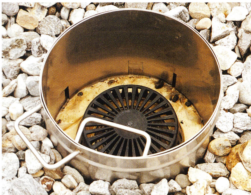
Bild 3. Ablauf mit ineinander verlaufenden Rückhalteringen mit zwei sichtbaren Schlitzöffnungen.
