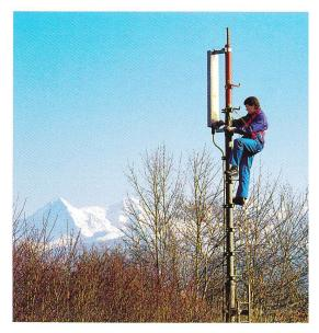
Bild 5. Montage der Outdoor-Anlage (Sender/Empfänger für Natel). Toni Stadelmann: «Die Ausbreitungseigenschaften eines digitalen Funknetzes (Natel D) kann durch Reflexionen von Häusern, Hügeln und Bergen sowie durch erhöhte Dämpfungswerte von Scheiben, Mauern, Gebäuden und Wäldern beeinträchtigt werden.»
