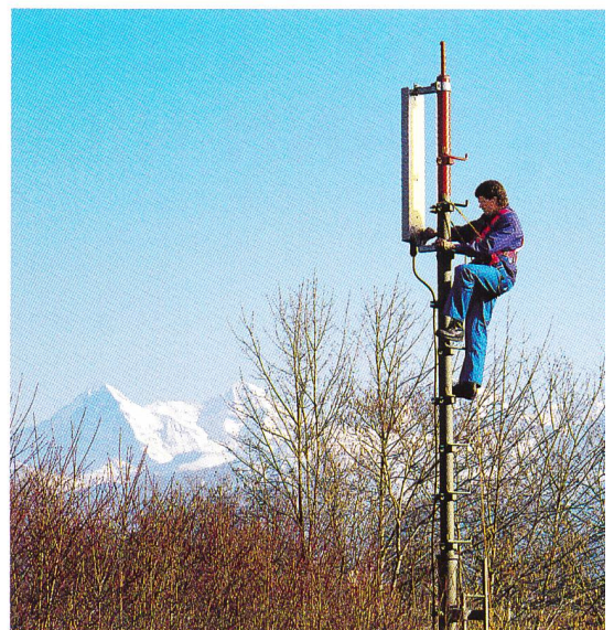
Bild 5. Montage der Outdoor-Anlage (Sender/Empfänger für Natel).
