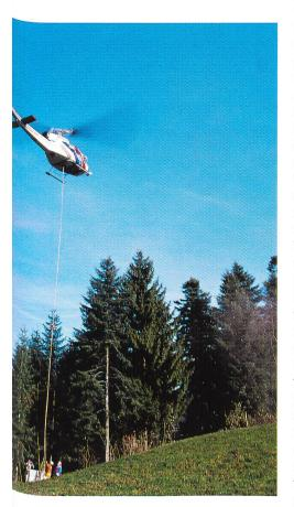
Bild 3. Ein Antennenmast wird per Heli angeliefert.
