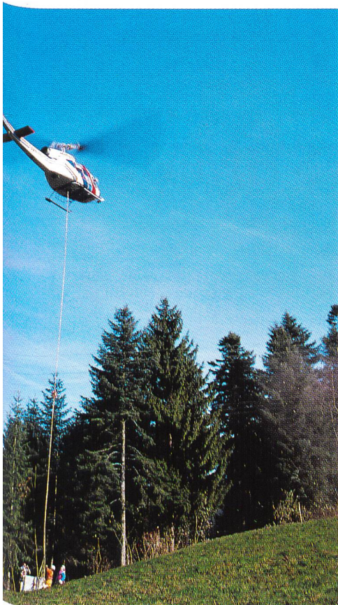
Bild 3. Ein Antennenmast wird per Heli angeliefert.
