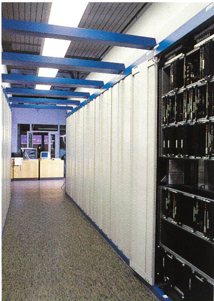
▲ Bild 4. Die IDZ bildet das Kernstück der ASA. Sie schaltet pro Anrufer nur diejenigen Systemteile an, welche in der entsprechenden Phase des Anrufs (Begrüßung, Suche, Rufnummernansage und Wiederpräsentation) nötig sind (Bilder 4 und 7 bis 10: Erhard Hofer, Telecom PTT).
