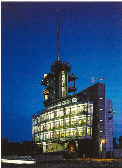
Bild 1. Das Telekommunikationszentrum Odyssea der Telecom PTT in Ecublens als Kommunikationsdrehscheibe in der Westschweiz.
