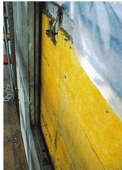
Aufgehängte Betonfassade, oben das Aufhängesystem.
