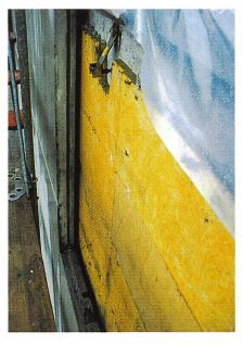
Aufgehängte Betonfassade, oben das Aufhängesystem.
