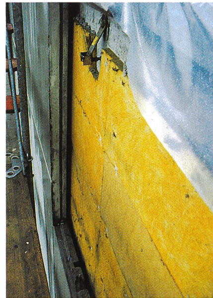
Aufgehängte Betonfassade, oben das Aufhängesystem.
