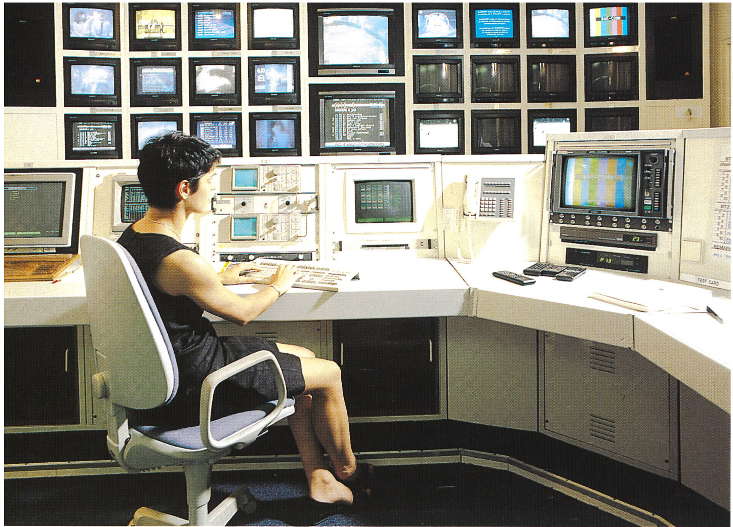
Kontrollraum und Bildregie bei S. E. S. Luxembourg für TV-Programme via Satellit. (Foto: H. R. Bramaz)
