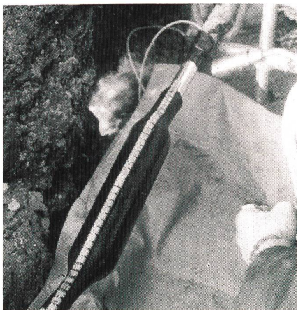
Installation einer XAGA-500-Verbindungs-muffe mit integrierter Feuchtigkeitssperre
