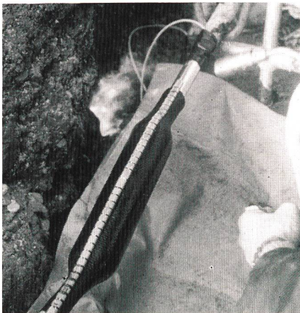
Installation einer XAGA-500-Verbindungs-muffe mit integrierter Feuchtigkeitssperre
