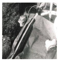
Installation einer XAGA-500-Verbindungsmuffe mit integrierter Feuchtigkeitssperre
