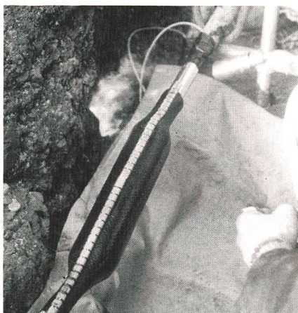
Installation einer XAGA-500-Verbindungs-muffe mit integrierter Feuchtigkeitssperre
