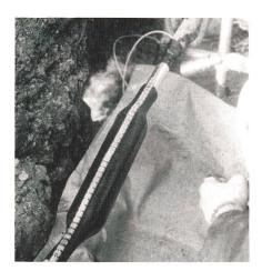
Installation einer XAGA-500-Verbindungsmuffe mit integrierter Feuchtigkeitssperre
