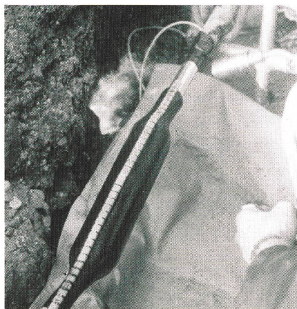
Installation einer XAGA-500-Verbindungs-muffe mit integrierter Feuchtigkeitssperre
