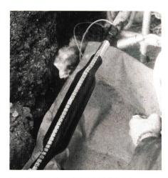
Installation einer XAGA-500-Verbindungsmuffe mit integrierter Feuchtigkeitssperre
