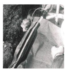
Installation einer XAGA-500-Verbindungsmuffe mit integrierter Feuchtigkeitssperre
