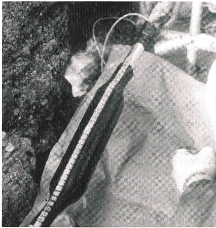
Installation einer XAGA-500-Verbindungs-muffe mit integrierter Feuchtigkeitssperre
