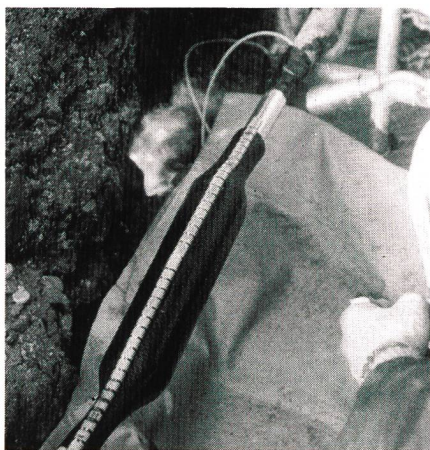
Installation einer XAGA-500-Verbindungs-muffe mit integrierter Feuchtigkeitssperre
