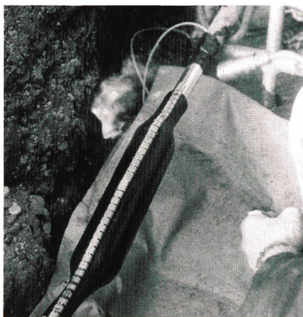
Installation einer XAGA-500-Verbindungs-muffe mit integrierter Feuchtigkeitssperre
