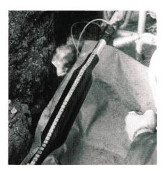
Installation einer XAGA-500-Verbindungsmuffe mit integrierter Feuchtigkeitssperre
