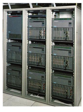
Fig. 3 SIMUX 3645 Cross-Connect numérique, de moyenne taille, utilisé dans l'épine dorsale MilaNet et le niveau interurbain. Extension possible jusqu'à une capicité de commutation de 512 Mbit/s.
