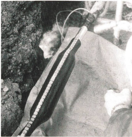
Installation einer XAGA-500-Verbindungs- und Abzweigmuffe mit integrierter Feuchtigkeitssperre
