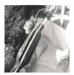
Installation einer XAGA-500-Verbindungsmuffe mit integrierter Feuchtigkeitssperre
