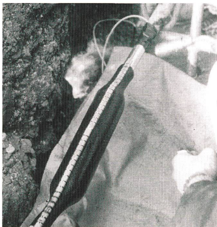
Installation einer XAGA-500-Verbindungs-muffe mit integrierter Feuchtigkeitssperre
