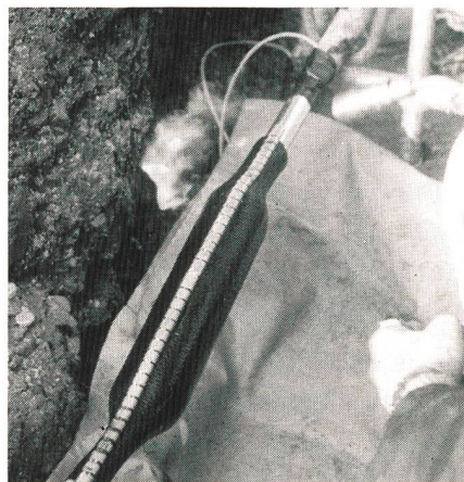
Installation einer XAGA-500-Verbindungs-muffe mit integrierter Feuchtigkeitssperre
