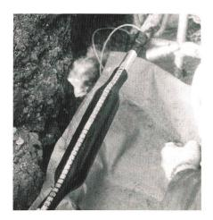
Installation einer XAGA-500-Verbindungsmuffe mit integrierter Feuchtigkeitssperre
