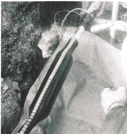
Installation einer XAGA-500-Verbindungs-muffe mit integrierter Feuchtigkeitssperre
