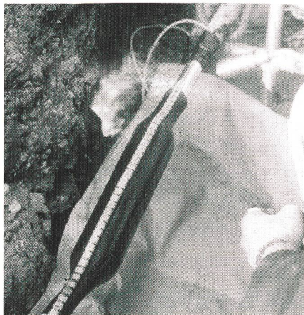
Installation einer XAGA-500-Verbindungs-muffe mit integrierter Feuchtigkeitssperre
