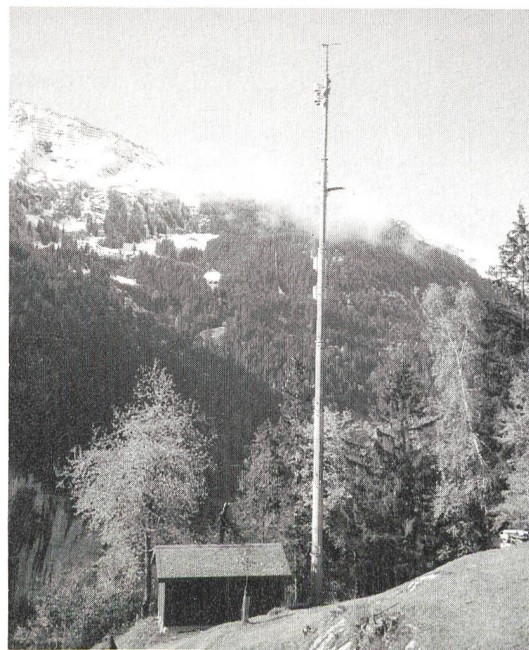
Fig. 25 Telepage swiss versorgt auch die Voralpentäler. Gemeinsamer Standort von Natel C und Telepage swiss
