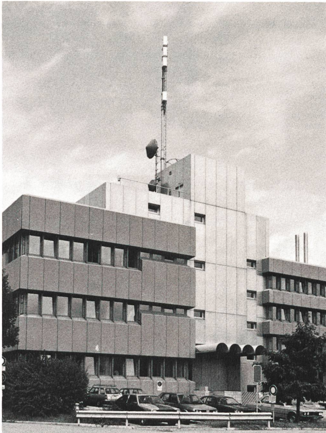
Fig. 14 Standorte von neuen Basisstationen (BTS) bei PTT-Gebäuden (Ittigen)
