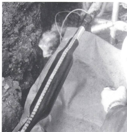
Installation einer XAGA-500-Verbindungs-muffe mit integrierter Feuchtigkeitssperre
