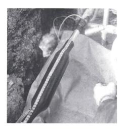
Installation einer XAGA-500-Verbindungsmuffe mit integrierter Feuchtigkeitssperre
