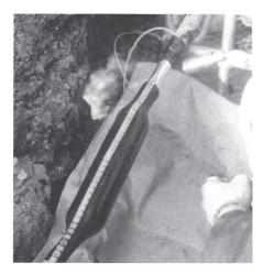
Installation einer XAGA-500-Verbindungsmuffe mit integrierter Feuchtigkeitssperre
