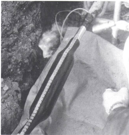
Installation einer XAGA-500-Verbindungs-muffe mit integrierter Feuchtigkeitssperre
