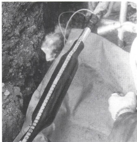
Installation einer XAGA-500-Verbindungs-muffe mit integrierter Feuchtigkeitssperre
