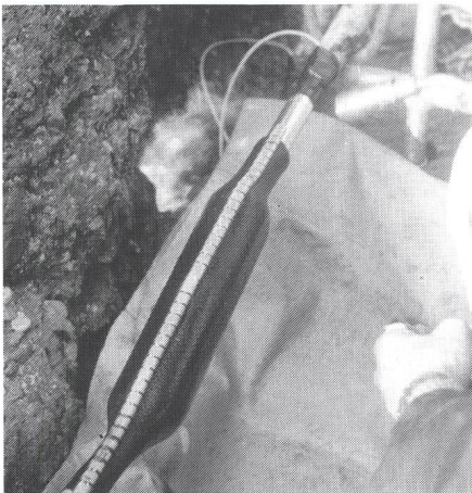
Installation einer XAGA-500-Verbindungs-muffe mit integrierter Feuchtigkeitssperre
