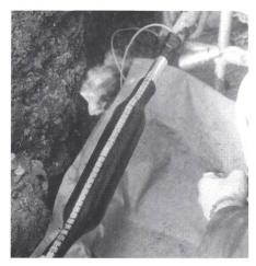
Installation einer XAGA-500-Verbindungsmuffe mit integrierter Feuchtigkeitssperre
