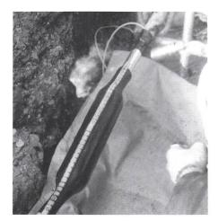
Installation einer XAGA-500-Verbindungsmuffe mit integrierter Feuchtigkeitssperre
