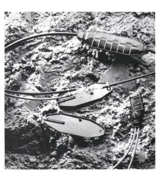
Einfache Schutzmuffe für moderne Telefonkabelspleissungen bis max. 30 Ader-
