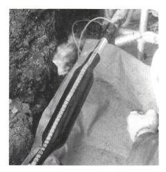
Installation einer XAGA-500-Verbindungsmuffe mit integrierter Feuchtigkeitssperre
