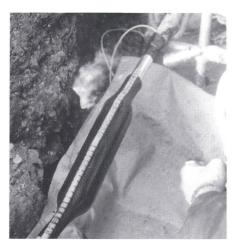
Installation einer XAGA-500-Verbindungsmuffe mit integrierter Feuchtigkeitssperre
