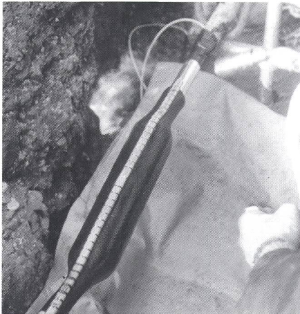
Installation einer XAGA-500-Verbindungs-muffe mit integrierter Feuchtigkeitssperre
