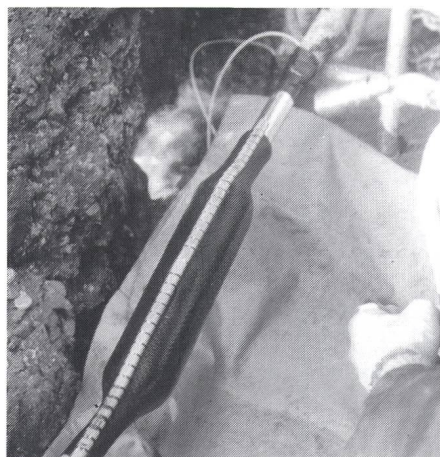
Installation einer XAGA-500-Verbindungs-muffe mit integrierter Feuchtigkeitssperre
