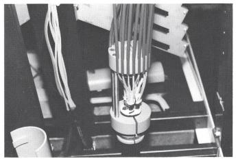
Fig. 12 Aufteiler für Bandfaserkabel
