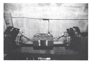
Fig. 10 Muffe mit Spleisskassetten
