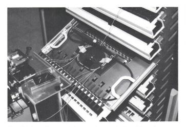
Fig. 14 Bandfaserspleissung im optischen Verteiler
