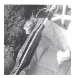
Installation einer XAGA-500-Verbindungsmuffe mit integrierter Feuchtigkeitssperre
