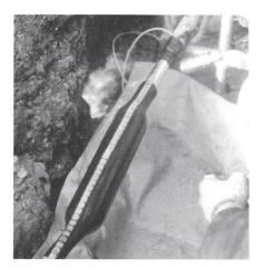
Installation einer XAGA-500-Verbindungsmuffe mit integrierter Feuchtigkeitssperre
