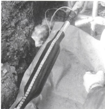
Installation einer XAGA-500-Verbindungs-muffe mit integrierter Feuchtigkeitssperre
