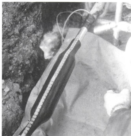
Installation einer XAGA-500-Verbindungs-muffe mit integrierter Feuchtigkeitssperre
