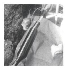
Installation einer XAGA-500-Verbindungsmuffe mit integrierter Feuchtigkeitssperre
