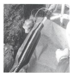
Installation einer XAGA-500-Verbindungsmuffe mit integrierter Feuchtigkeitssperre
