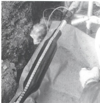
Installation einer XAGA-500-Verbindungs-muffe mit integrierter Feuchtigkeitssperre
