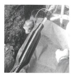
Installation einer XAGA-500-Verbindungsmuffe mit integrierter Feuchtigkeitssperre
