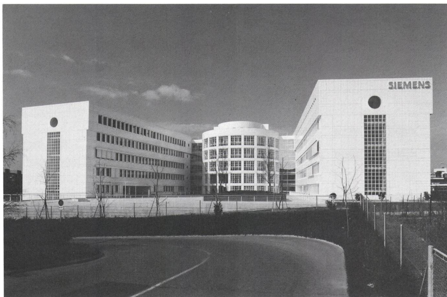
Neues «Centre Siemens» in Renens
