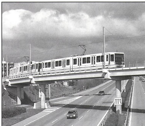
Le TSOL relie les Hautes Ecoles lausannoises (UNIL et EPFL) au centre de la ville.
