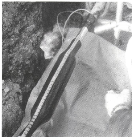
Installation einer XAGA-500-Verbindungs-muffe mit integrierter Feuchtigkeitssperre
